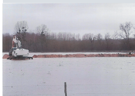
Pelleteuse à chenilles supprimant le samedi un merlon de protection du plan d'eau à Pont/Seine
