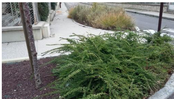
Aménagement permettant l'infiltration de l'eau de pluie - Brienne le Château (source : agence de l'eau Seine Normandie)
