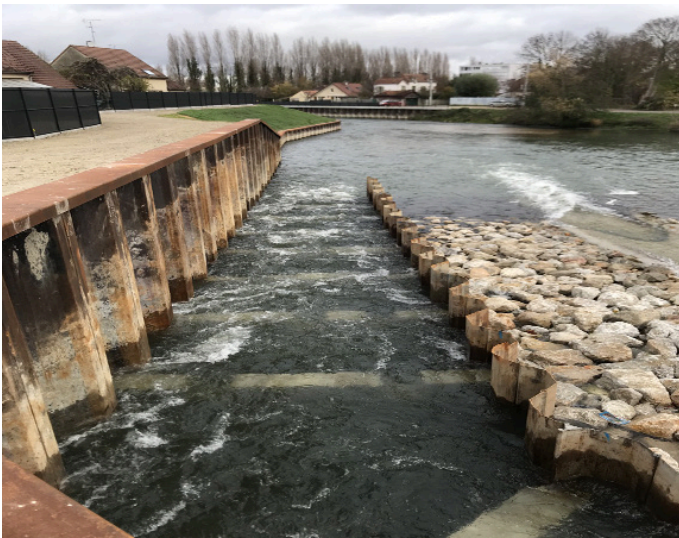
Aménagement d'une passe à poissons - Digue de Fouchy (déversoir de St Quentin) - source : DDT
